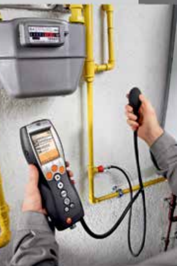
Test szczelności instalacji gazowej
